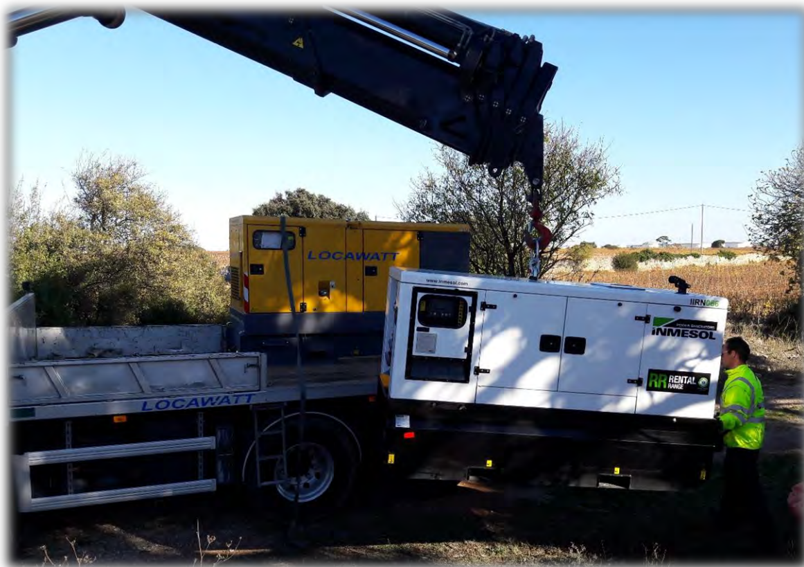
Illustration 8 - Dépose du groupe électrogène 60 kVA au TX2 – Frontignan.
