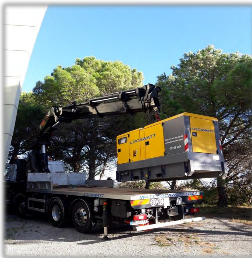
Illustration 5 - Dépose du groupe électrogène 60 kVA au TX1 - Loupian.
